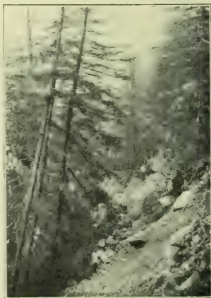
FIG. 155. — CREVASSE FORMÉE EN PLEINE FORÊT PAR L'ÉROSION D'UNE BERGE DE TORRENT.
